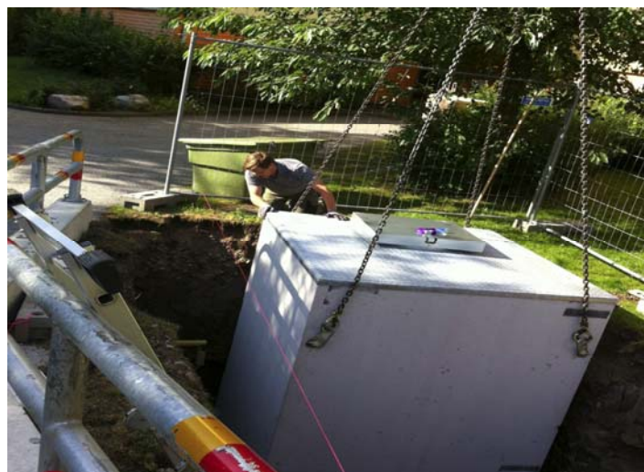
Nedlyftning och installation av avfallsbehållare
